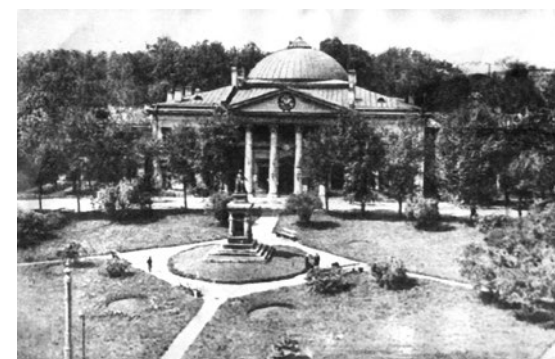
Административный корпус Военно-медицинской академии РККА (на фронтоне – герб РСФСР; на переднем плане – памятник Я.В. Виллие)
